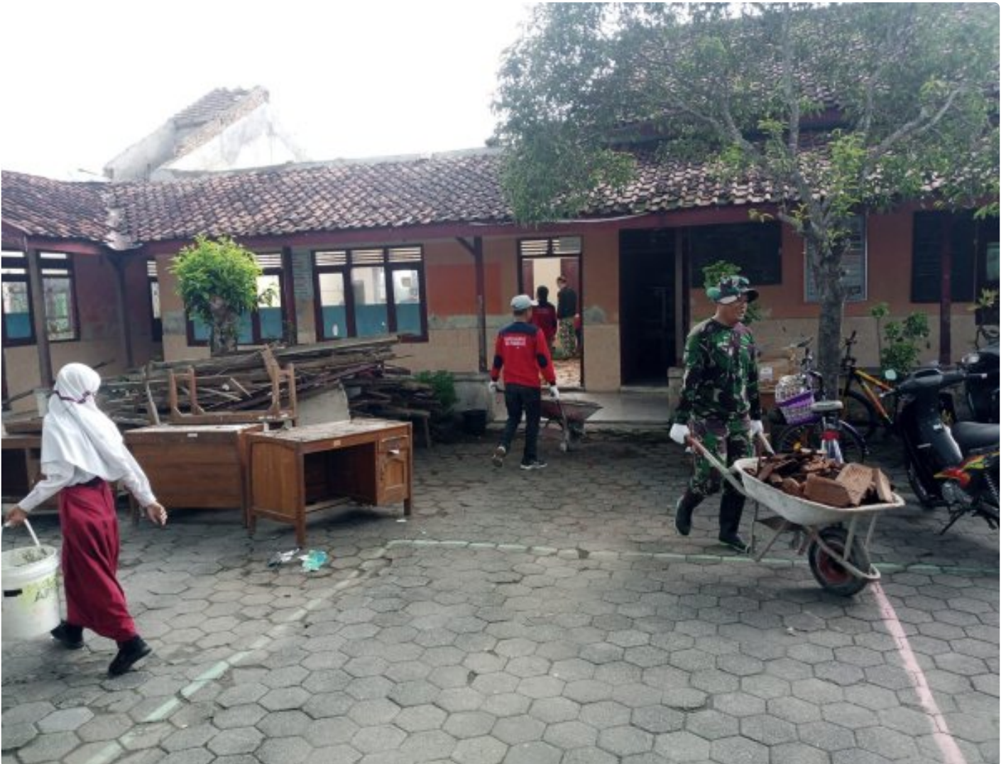
Babinsa Koramil 19 Trucuk Gotong Royong Pembersihan Gedung SDN 2 Pundungsari Yang Roboh
